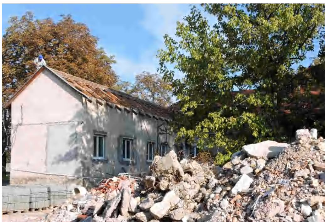
A múlt héten szerdán megkezdték az épület bontását
